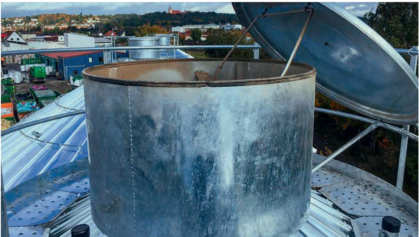
Domerhöhung mit Domplattform: Verzinktes Material sorgt für bessere Standsicherheit und somit höhere Sicherheit.
