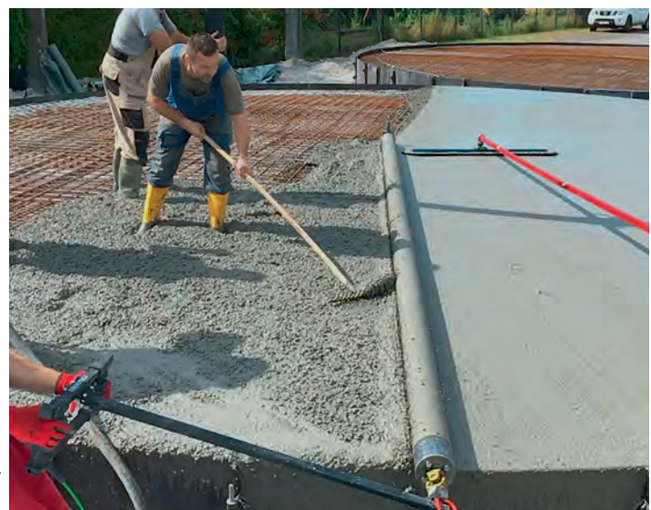
Hier ist Genauigkeit beim Bauen gefragt: Eine sehr ebene Bodenplatte im Getreidesilo ist eine Grundvoraussetzung.
